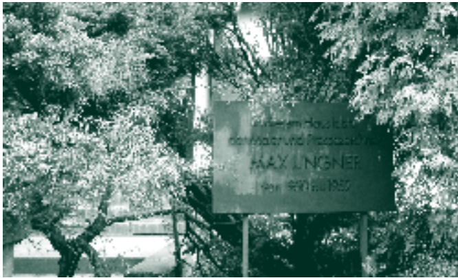
Von Grund auf saniert: das Max-Linger-Haus in Berlin-Pankow
