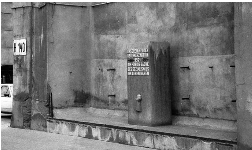
Bereits in der Wendezeit demoliert, der Gedenkstein an den Silos in den Leuna-Werken. Im Jahr 1992 mit den Silos abgerissen.
