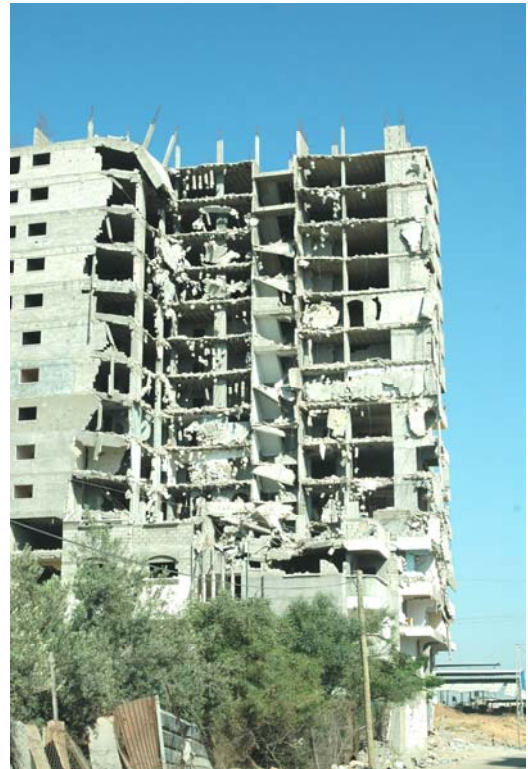
Bombardiertes Gebäude im Norden von Gaza-Stadt
